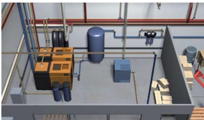
传统的压缩机：需要外部干燥和过滤设备，噪音比较高，必须放置在远离现场的地方。这增加了外部管网，增加了安装成本。
